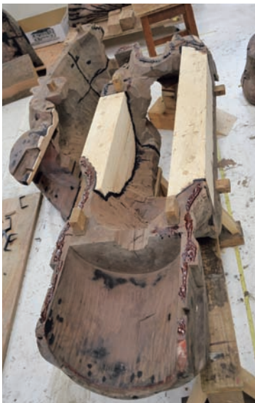
148 補強材の周辺に木屎漆を充填
