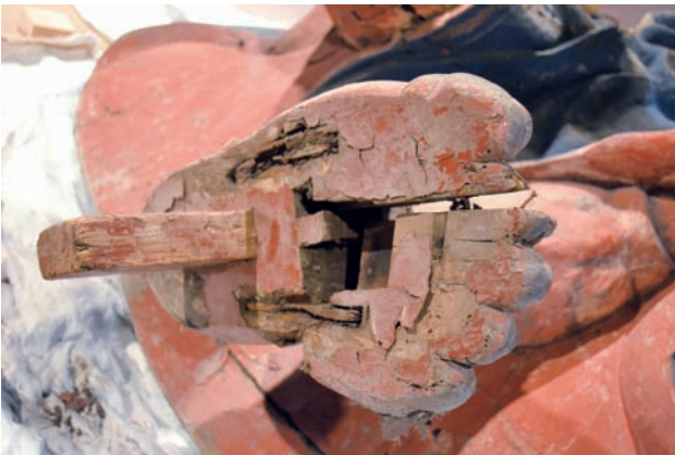
10 左足先の損傷と部材の脱落
