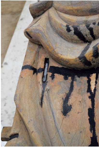
142 木屎漆を充填し、さらに鋸で補強
