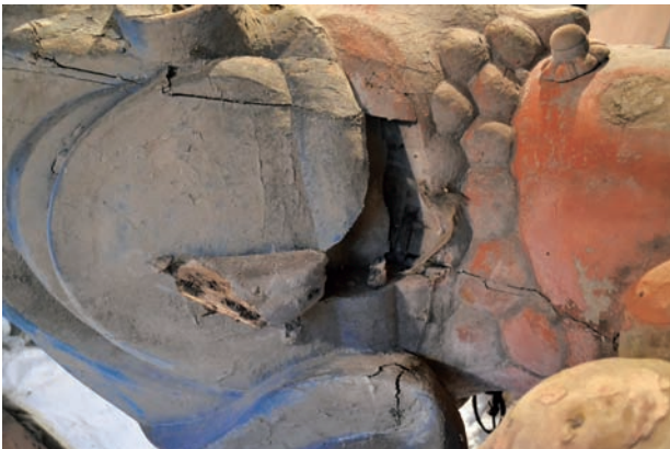
阿形像：左腹部と腰部の損傷状況
