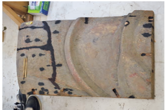
140 背面材に木屎漆で補修
