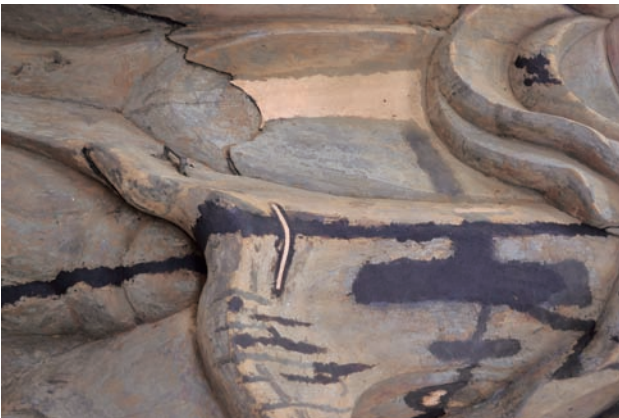
55 鋸(かすがい)を外した箇所に埋木をし、木屎漆を充填
