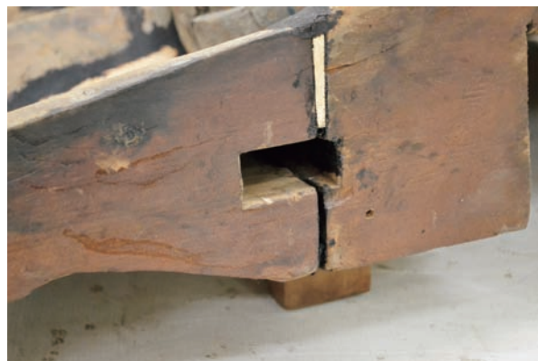
69 調整のため切断箇所に入れたマチ材
