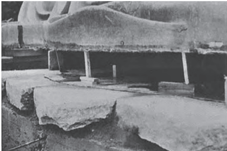
図4 台座の上に御影石を載せ、その上にステンレス板を置く
