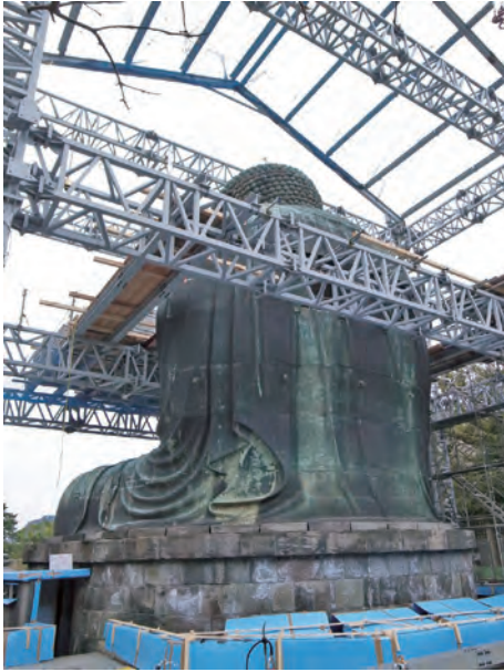
図42 作業床の設置
