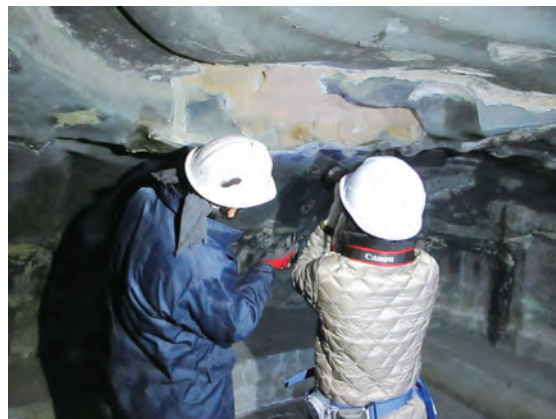
図92 損傷状態・技法調査(内部)
