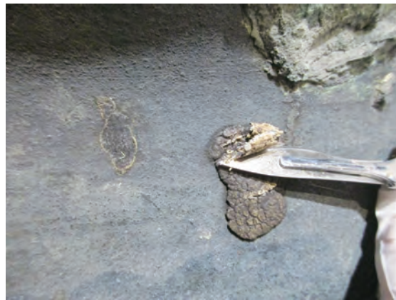
図95-3 硬化したチューインガムのメスによる物理的除去
