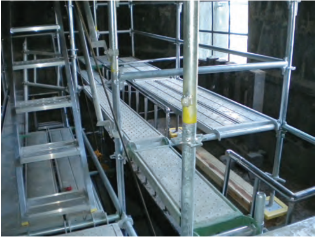
図54 尊像内部の足場
