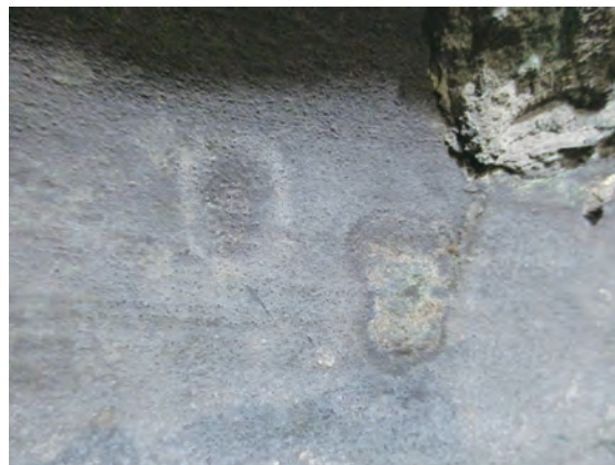
図95-5 硬化したチューインガムの除去後
