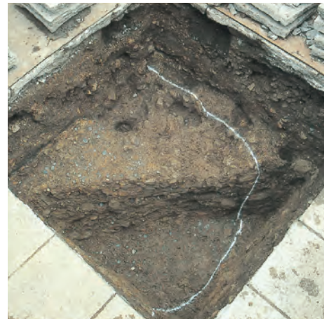
図11 平成13年度3区 大仏殿礎石下の根固め (『鎌倉大仏周辺の発掘調査～大仏造営手法と大仏殿の推定～』鎌倉市教育委員会 2002より転載)
