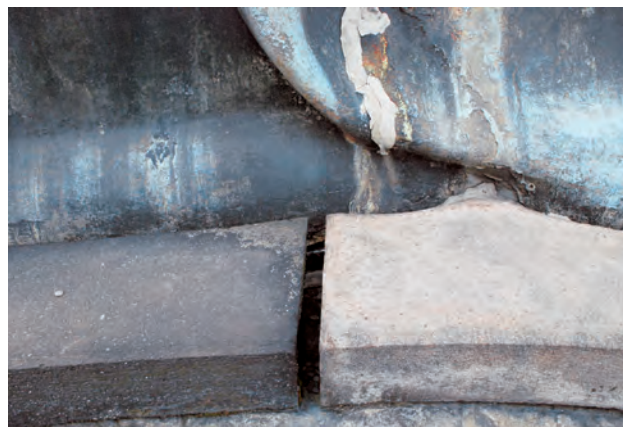
図162 ひび割れ部におけるコーキング剤の使用
