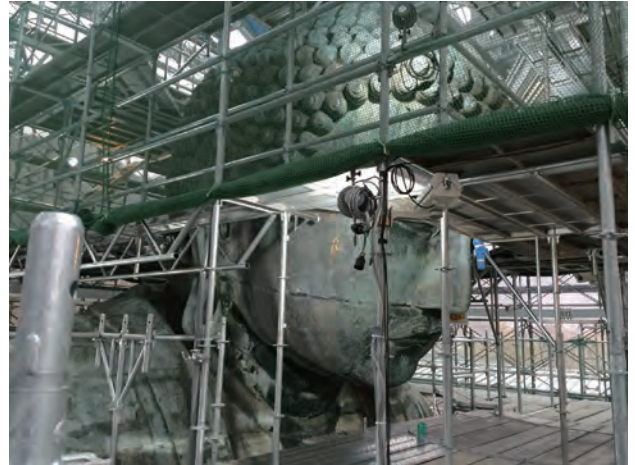
図49 作業床上の単管足場
