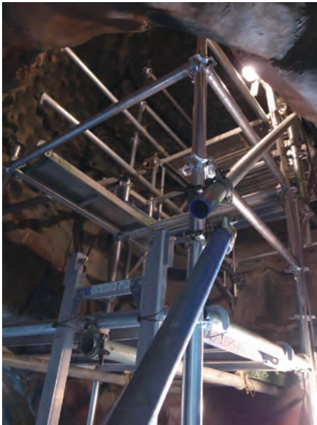
図56 尊像内部の足場
