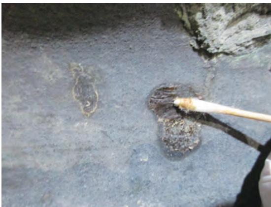
図95-4 硬化したチューインガムの化学薬品による除去
