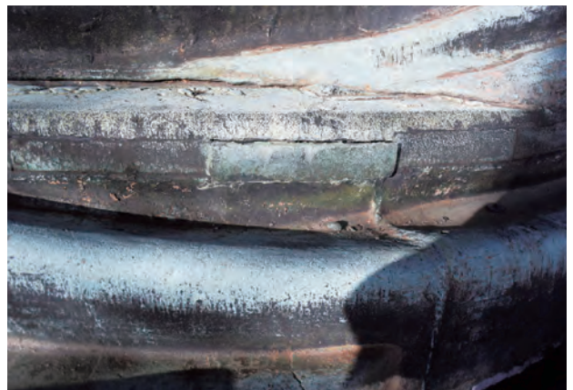
図160 埋め金の飛出し (台座)
