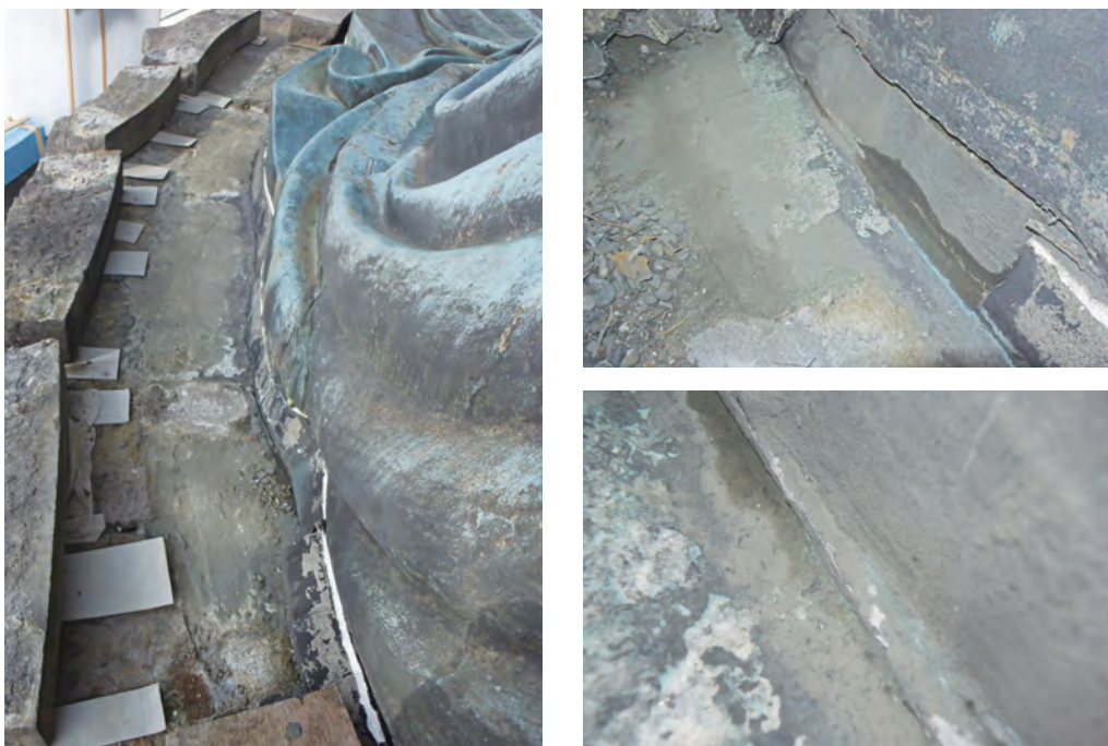
図99 地点1の化粧石取り外し状況（左）、ステンレス板現況（右上下）
