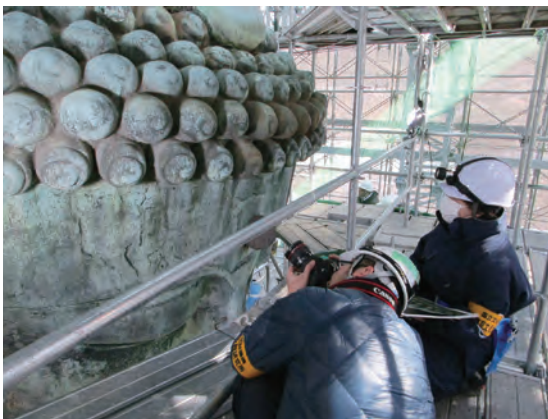
図91 損傷状態・技法調査(外部)
