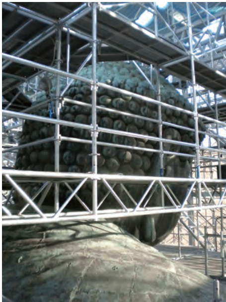
図50 作業床上の単管足場
