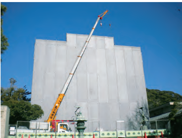
図46 メッシュシート設置
