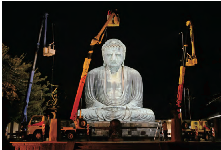
図13 高所作業車を3台使用
