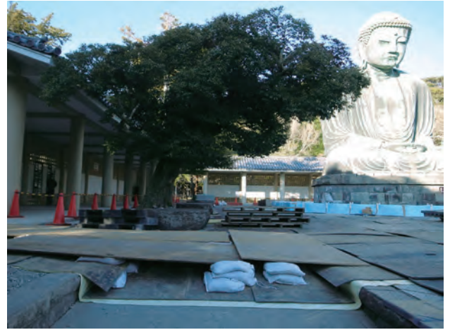
図37 工事用車両用通路及び地盤養生
