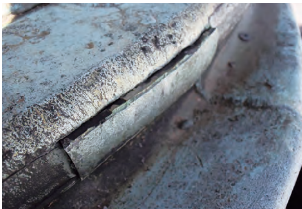
図161 埋め金の飛出し (台座)
