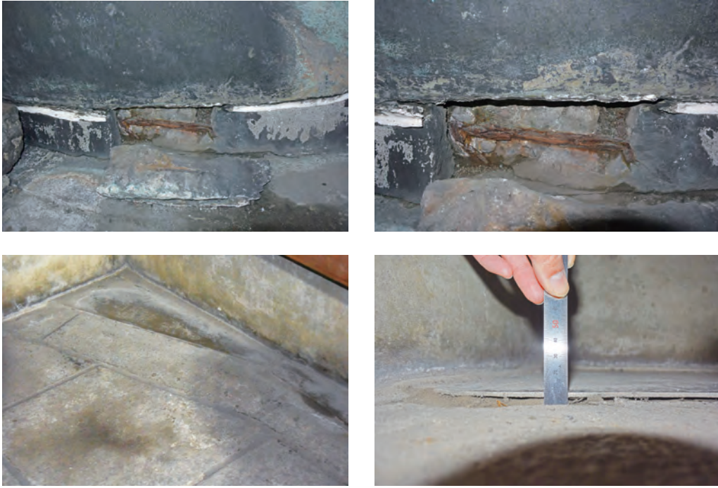
図101 地点3で見られた鉄筋の錆（上）および内部から見たステンレス板（下）
