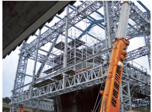
図45 作業床上の単管足場組立
