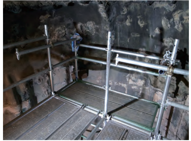
図55 尊像内部の足場
